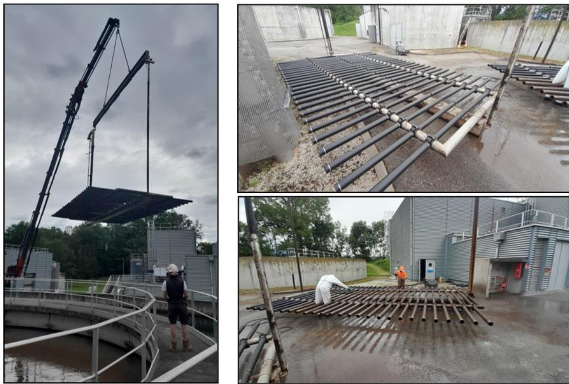
Levage et nettoyage des diffuseurs
