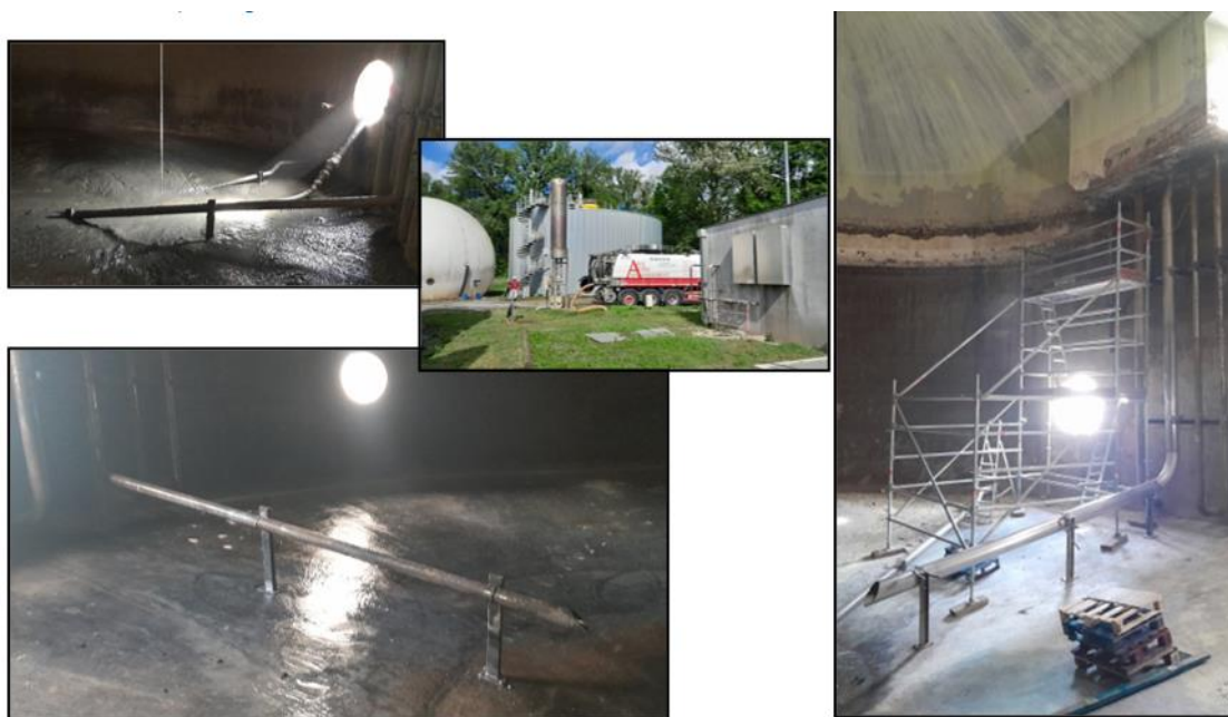
Vidange du digesteur 1200 m 3
