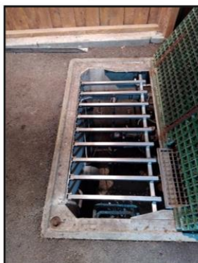
Installation de barreaudage antichute dans les PR
