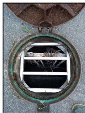
Installation de barreaudage antichute dans les PR
