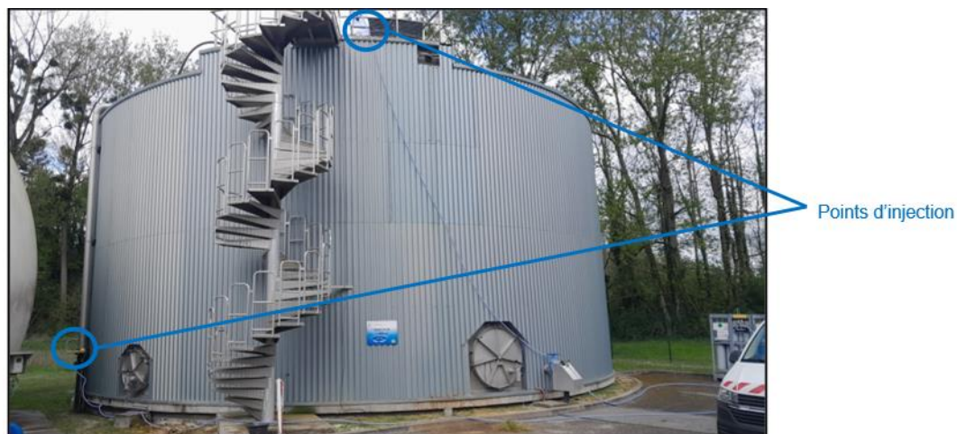
Inertage à l'azote avant vidange
