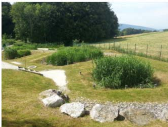
Station d'épuration de la Chapelle-Rambaud – source CC du Pays Rochois
