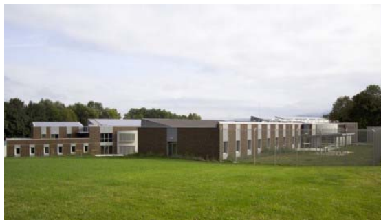
Hôpital à La Roche sur Foron - 150 kW en 2011
