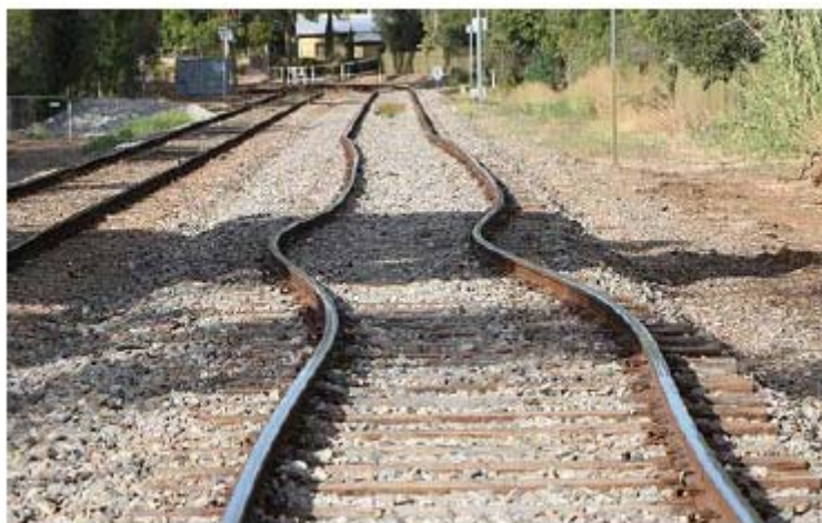
Déformation de rails lors de la canicule de 2003 sur la ligne de RER D
