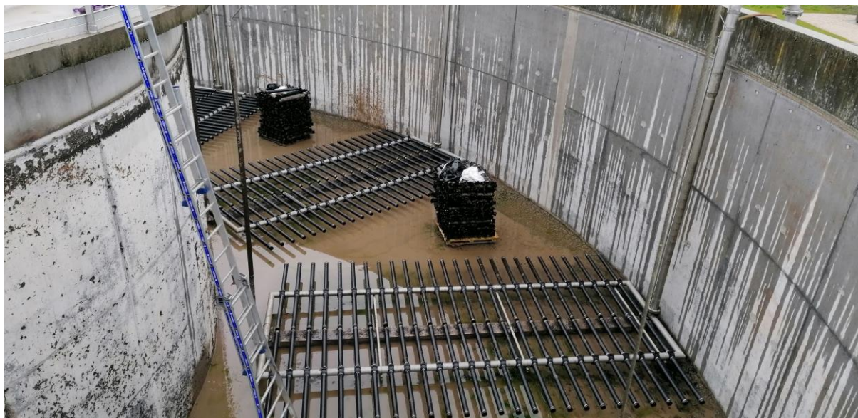
Vidange, nettoyage et changement des diffuseurs du bassin biologique – File B
