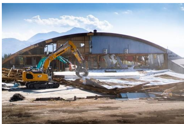
Démolition de l'ancien parc des expositions (2020)
